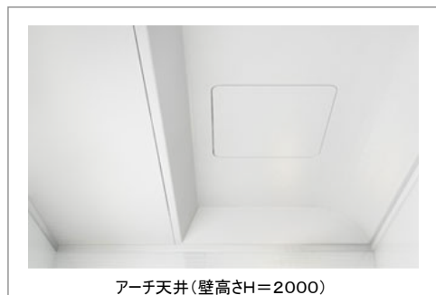
アーチ天井(壁高さH=2000)
